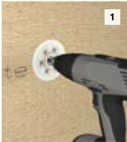
Die Weichfaserplatte mit Sto-Schraubdübeln H 60 am Untergrund befestigen. Einschraubtiefe in den tragenden Untergrund: mind. 25mm. Dübelteiler bündig zur Dämmstoffoberfläche einschrauben. Dübel keinesfalls zu tief einschrauben.
