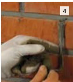
Stoßfugen per Hand mithilfe eines Fugeneisens verfugen. Anschließend den Fugenmörtel mit dem Fugeneisen verdichten.
