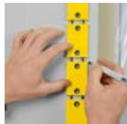
Die Verlegehilfe Sto-Flextool vereinfacht die Einteilung der Fassade. Die mit einem Gummi verbundenen Plättchen in Steinformat-Höhe geben die Fugenhöhe automatisch an.
