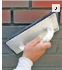
StoColl FM-S mit einem Schwammbrett als Schlämmverfugung in den kompletten Fugenquerschnitt einreiben. Um eine Farbgleichheit zu erzielen, ist eine gleichmäßige Verarbeitung unerlässlich. Um Farbdifferenzen zu verhindern, während der Verarbeitung kein zusätzliches Wasser zugeben.
