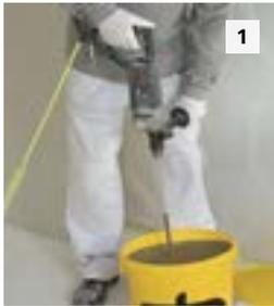
Ca. 2–3l Wasser pro 25-kg-Sack vorbereiten. Anschließend StoColl FM-K ca. 2 Minuten mit dem Rührwerk untermischen. Ca. 3 Minuten reifen lassen und anschließend nochmals gut durchmischen. Langsam drehendes Rührwerk (ca. 400U/min) verwenden und bei stark pigmentierten Sonderfarbtönen die geforderte Wassermenge mit 23 kg Trockenmörtel vormischen. Nach der Reifezeit die Restmenge Trockenmörtel einrühren.
