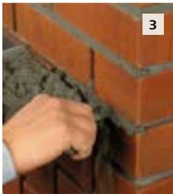
Lagerfuge mithilfe eines Fugeneisens (Fugeneisen, 8 mm) verfugen. Anschließend den Fugenmörtel mit dem Fugeneisen verdichten. Um eine Farbgleichheit zu erzielen, ist eine gleichmäßige Verarbeitung unerlässlich. Um Farbdifferenzen zu verhindern, während der Verarbeitung kein zusätzliches Wasser zugeben.
