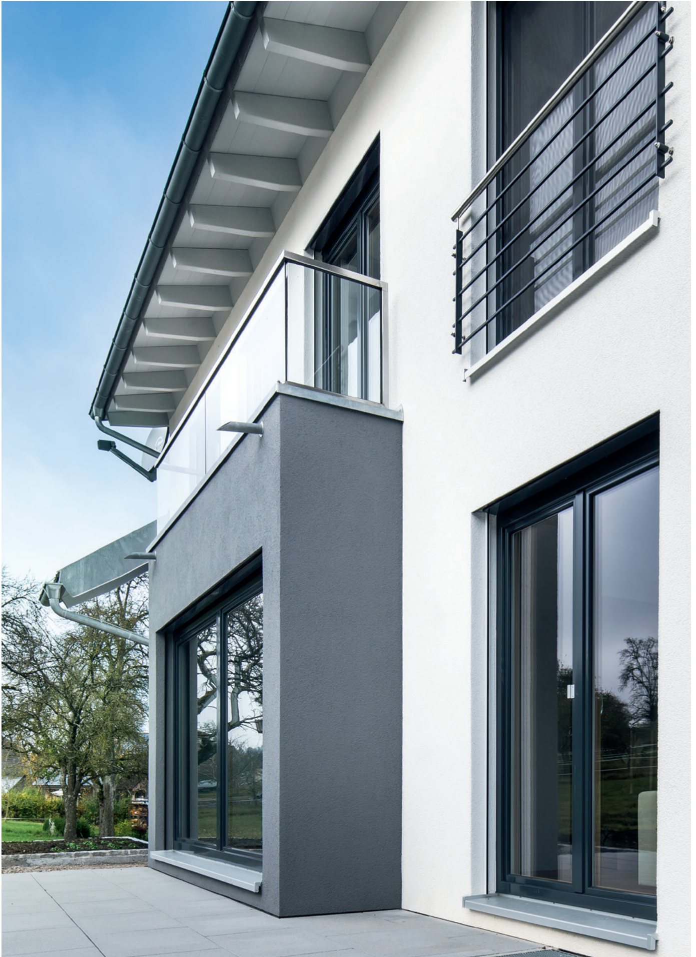
Einfamilienhaus, Wutach-Ewatingen Architekt: Ralf Kaiser, Grafenhausen System: StoTherm Wood Fotograf: Martin Baitinger, Böblingen
