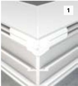
**1** Untere Diagonalnut sowie waagrecht und senkrecht verlaufende Blendrahmennut beidseitig mit StoColl Fix abfugen.
