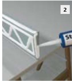
**2** StoColl Fix als umlaufende Kleberaube mit eingeschlossenem V aufbringen. Auf rückseitige und seitliche XPS-Kanten Kleberaube auftragen.
