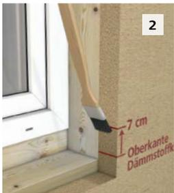
**2** Fensterbrüstung vorreinigen und Untergründe mit illbruck ME904 vorstreichen. Mindestapplikationshöhe: 7cm über der Oberkante des Dämmstoffkeils.
