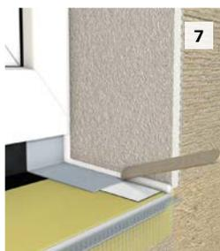
7 Plattenstöße und Übergänge mit StoColl Fix oder StoSeal F 100 vollständig ausfugen und glatt streichen.
