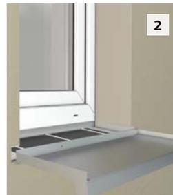
Auf der Rückseite des Anschraubstegs des StoFentra Fensterbankprofils das Sto-Fugen-dichtband Lento anbringen. Seitlich auf das Fensterbankprofil die Aufsteckprofile aufbringen. Das Fensterbankprofil in die StoFentra Slider einschieben und in das Kleberbett eindrücken.
