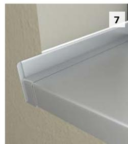
7 Das Abdeckprofil des Gleitabschluss Duos über der seitlichen Bewegungsfuge anbringen.
