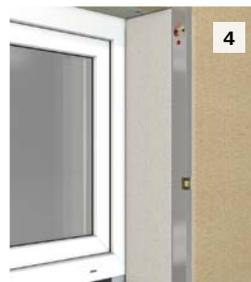
Beim Kleben mit Sto-Turbofix Mini die verlegten Laibungselemente nach max. 10 min mit einer Waaserwaage nachdrücken und ggf. ausrichten.
