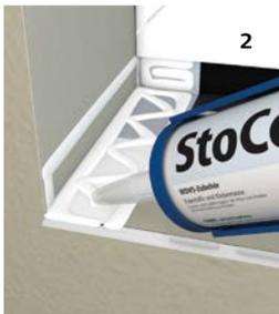
2 StoColl Fix oder StoSeal F 100 im Bereich des Gleitabschluss Duos als umlaufende Kleberaube mit eingeschlossenem V vorlegen. Zur seitlichen Verklebung StoColl Fix oder StoSeal F 100 auf das Laibungselement sowie auf die Innenecke aufbringen.
