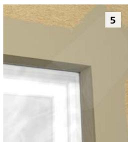
**5** Armierungsmasse vorlegen. Anschließend den Sto-Sturzeckwinkel vollständig einbetten.
