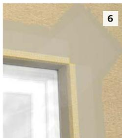
**6** Sto-Gewebewinkel auf Laibungslänge und Sturzbreite zuschneiden. Vollständig in vorverlegte Armierungsmasse einbetten.
