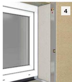
4 Beim Kleben mit Sto-Turbofix Mini die verlegten Laibungselemente nach max. 10 min mit einer Wasserwaage nachdrücken und ggf. ausrichten.
