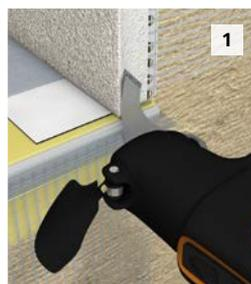
1 Maß des Laibungselements abnehmen und ggf. zuschneiden. Anputzleiste und Tropfkante des Dämmkeils im Bereich des Laibungselements ausschneiden.
