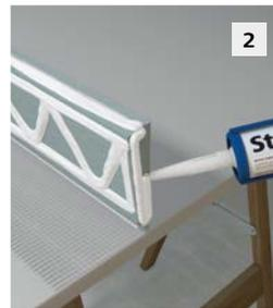
2 StoColl Fix oder StoSeal F 100 als umlaufende Kleberaube mit eingeschlossenem V aufbringen. Auf rückseitige und seitliche XPS-Kanten Kleberaube auftragen.
