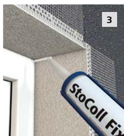
3 Laibungselement in den Sturz einsetzen, ausrichten und mit StoColl Fix oder StoSeal F 100 abfugen. Zusätzlich Lage des Laibungselements fixieren.
