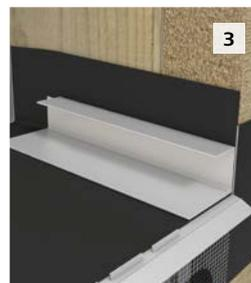
3 StoFentra Slider bündig zum Unterputz einkleben. Zur Erhöhung der Sicherheit kann dieser auch um ca. 5 mm über den Oberputz auskragen.
