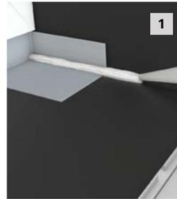
Kleberaube auf Dichtband und Innenecke auftragen.
