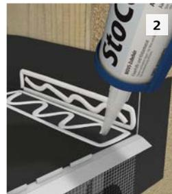
2 StoFentra Slider in passender Länge bzw. Größe mit StoColl Fix oder StoSeal F 100 einkleben.
