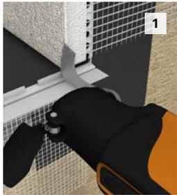
Maß des Laibungselements abnehmen und ggf. zuschneiden. Anputzleiste und Tropfkante im Bereich des Laibungselements ausschneiden.
