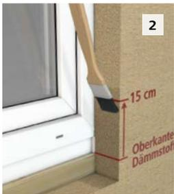
**2** Fensterbrüstung vorreinigen und Untergründe mit illbruck ME904 vorstreichen. Mindestapplikationshöhe: 15 cm über der Oberkante des Dämmstoffkeils.
