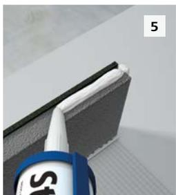
5 StoColl Fix oder StoSeal F 100 auf die hintere EPS-Kante des Laibungselements (bis in Höhe 7 cm von unten) auftragen. Fugendichtband darf nicht mit StoColl Fix oder StoSeal F 100 verklebt werden.
