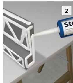
**2** StoColl Fix oder StoSeal F 100 als umlaufende Kleberaube mit eingeschlossenem V aufbringen. Auf rückseitige und seitliche EPS-Kanten Kleberaube auftragen.
