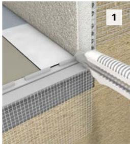
1 Maß des Laibungselements abnehmen und ggf. zuschneiden. Entwässerungsstege im Bereich des einzusetzenden Laibungselements entfernen.
