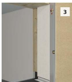
Beim Kleben mit Sto-Turbofix Mini die verlegten Laibungselemente nach max. 10 min mit einer Wasserwaage nachdrücken und ggf. ausrichten.
