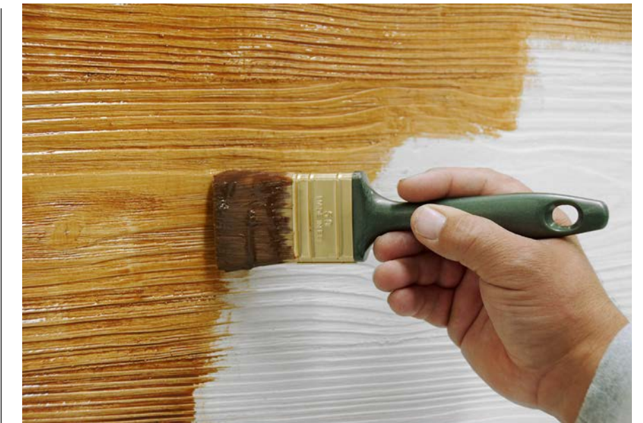
Eine zweifache Lasur unterstreicht die Holzoptik der Fassadenpaneele StoVeneer Wood und schützt die Oberfläche vor der Witterung.
